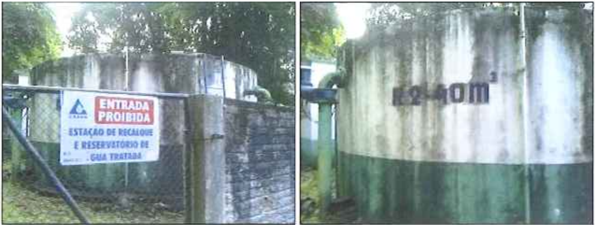
Figura 13: Reservatório R02 – 40 m 3
