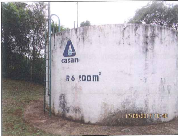
Figura 7: Imagem do Reservatório R6.
