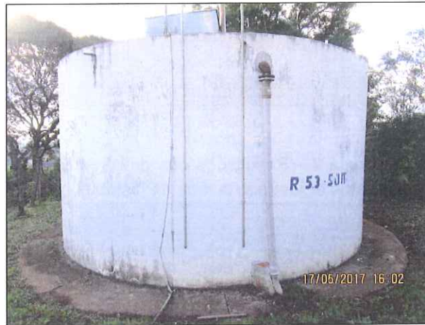
Figura 16: Imagem do Reservatório R5.3.
