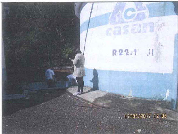
Figura 11: Imagem do Reservatório R2.2A
