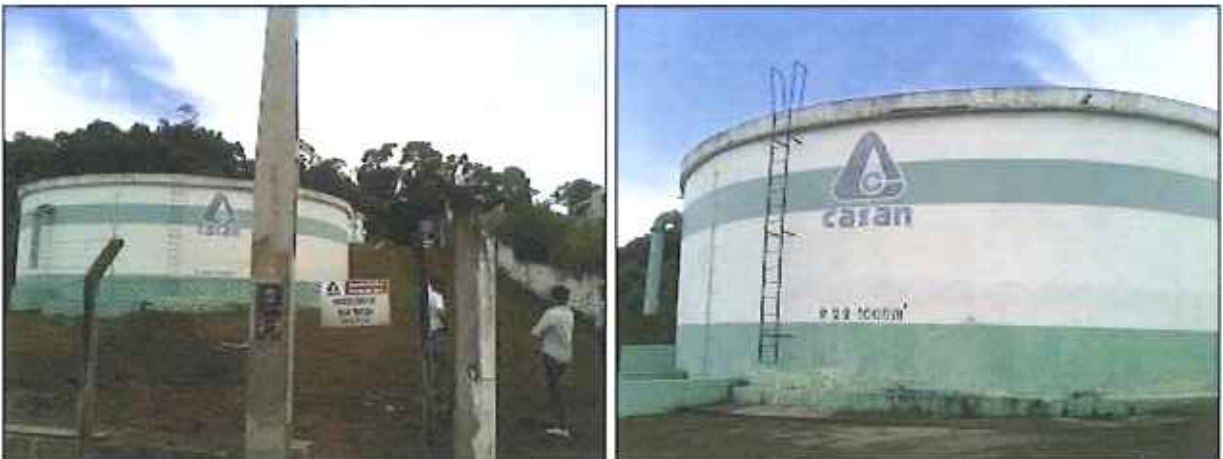
Figura 15: Reservatório R02.2 – 1000 m 3
