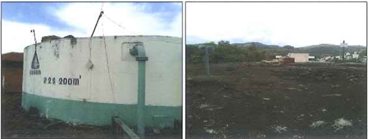
Figura 14: Reservatório R02.1 – 200 m 3
