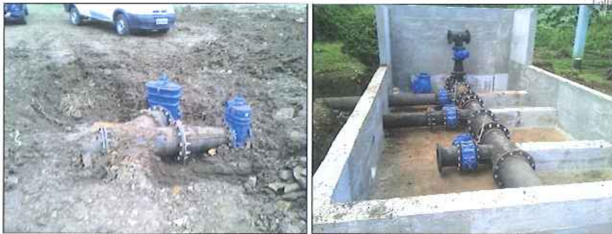
Figura 55: Obras de melhorias para aumentar a capacidade de recalque de água bruta
