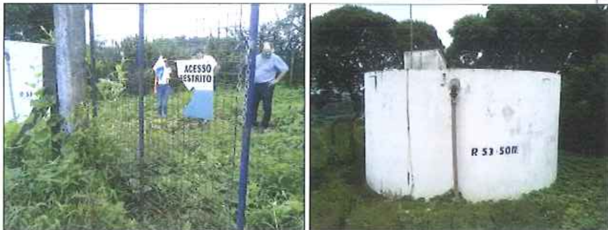
Figura 28: Reservatório R05.3 – 50 m 3
